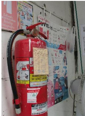
รูปที่ 26 ป้ายตรวจเช็คสภาพการใช้งานถังดับเพลิง
