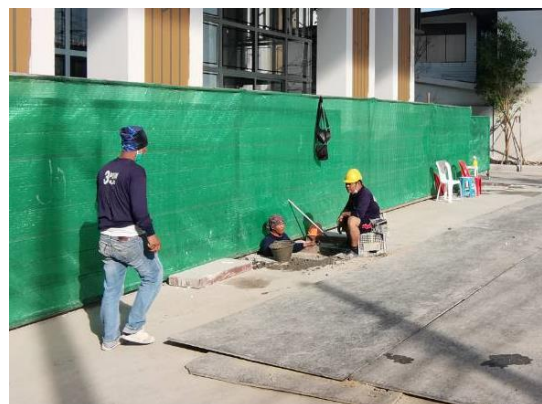
รูปที่ 23 ขุดลอกท่อระบายน้ำของโครงการก่อนการส่งมอบอาคาร
