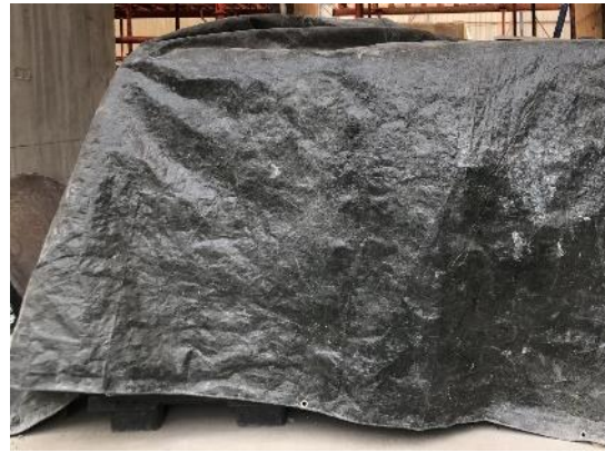
รูปที่ 13 การปิดคลุมถุงปูนซีเมนต์ผง
